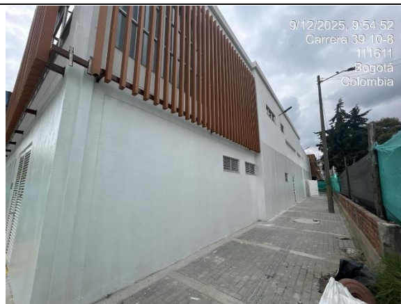
Aplicación de pintura antivandálica en fachada lateral
